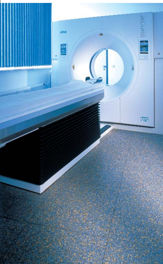
Für eine störungsfreie Funktion des Computertomographen verlegte man im CT-Raum des Krankenhauses Bad Cannstatt ableitfähige PVC-Fliesen.
