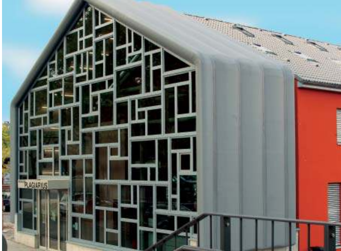
Stimmige Fassadenoptik: beschichtete Kunststoff-Profile und PVC-Dachbahnen, die das Fenster-Mosaik einrahmen.
