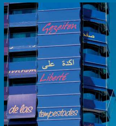
Auszüge aus dem Gedicht „Liberté“ von Paul Eluard verziern die Hotel-Fassade.
