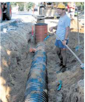
Verlegung von Jumbo-KG-PVC-Rohren für die Regenwasserkanalisation in der Ortsdurchfahrt Schweinitz.
