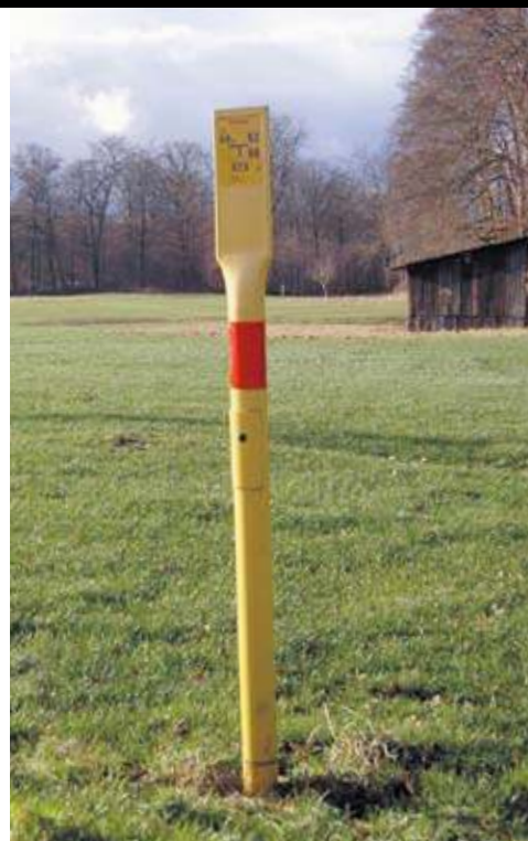
Messstellenpfosten geben wichtige Hinweise über den Verlauf unterirdischer Leitungen.
