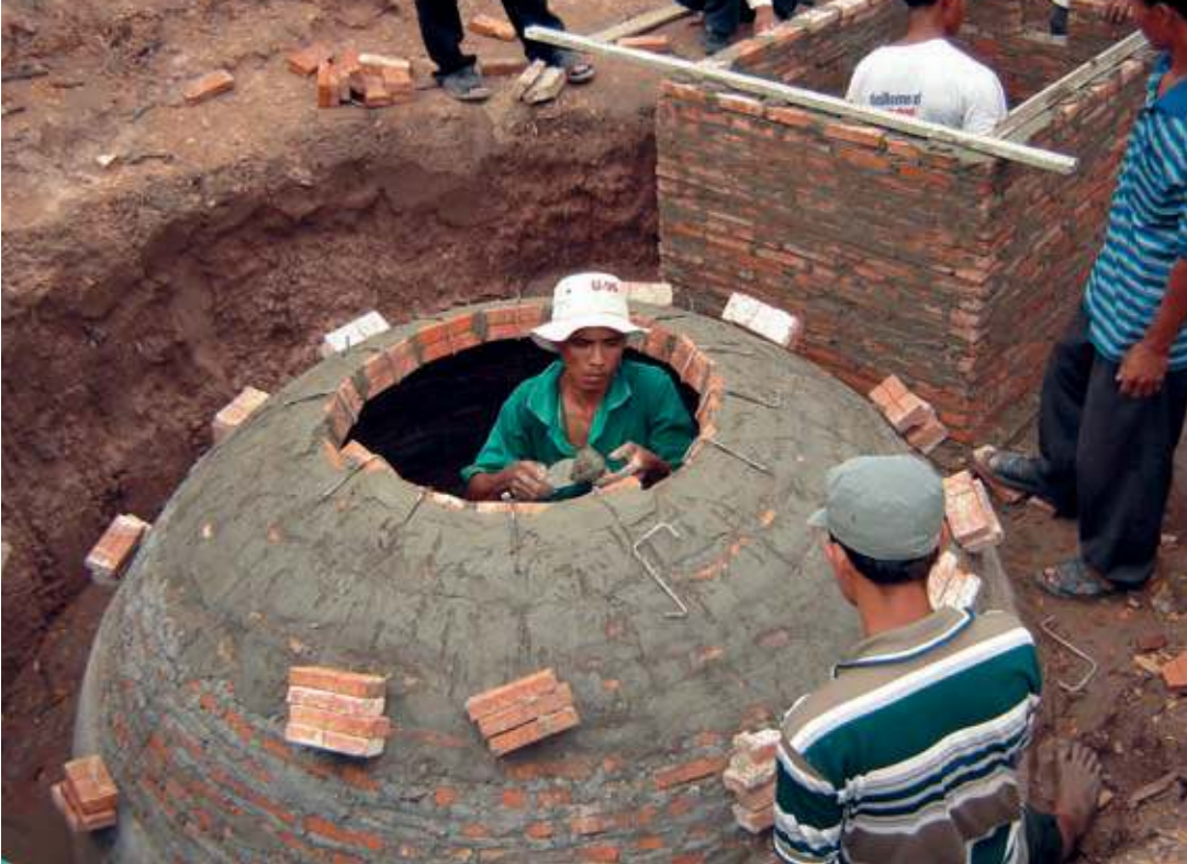
Biogas-Anlage kurz vor ihrer Fertigstellung.
