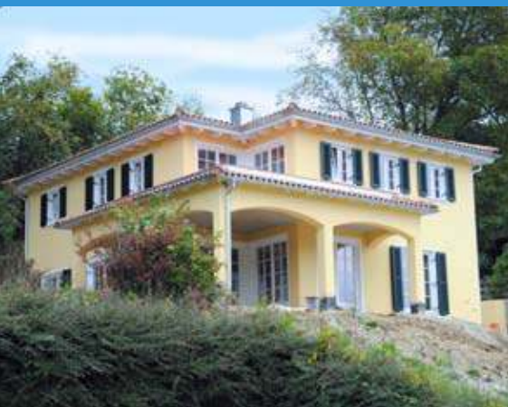
Traumhaus am Chiemsee: Auch hier prägen PVC-Fenster-Profile das Gesicht der Fassade.
