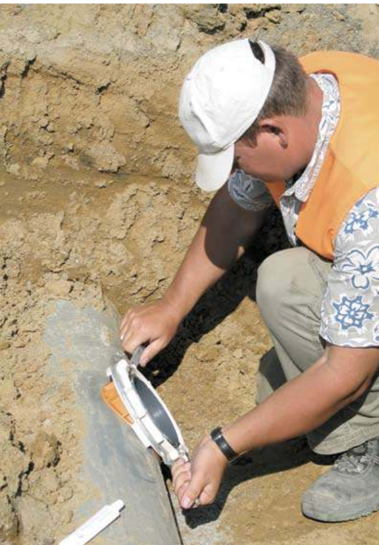
Mit dem flexiblen Formteil lassen sich Hausanschlüsse und Seitenzuleufe schnell und einfach in den Sammler einbinden.
