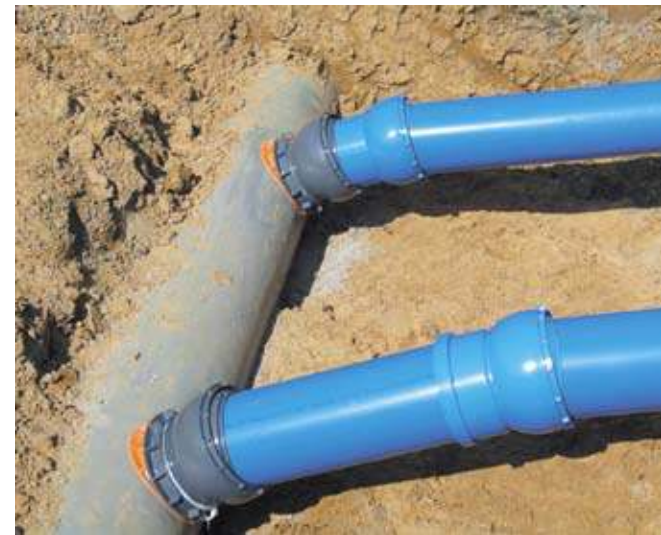
Perfekter Hausanschluss: die HS-VARIOmuffe im Einsatz.
