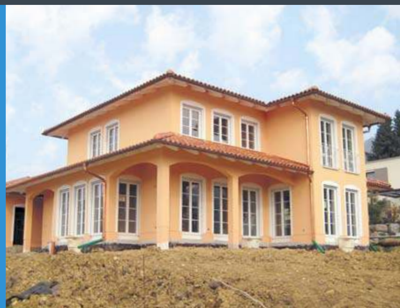
Bezugsfertig: formvollendetes Mediterranhaus am Bodensee in Österreich mit weissen Fensterrahmen aus PVC.
