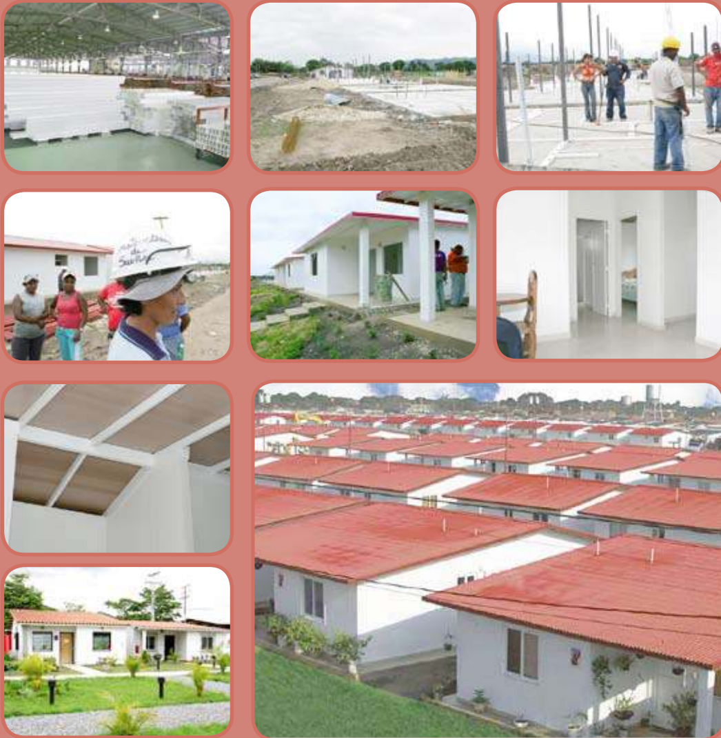
Mit dem Bau von PetroCasas erhalten viele Menschen in Venezuela ein neues Zuhause. Die Neubauten enthalten viele Bauprodukte aus PVC.
