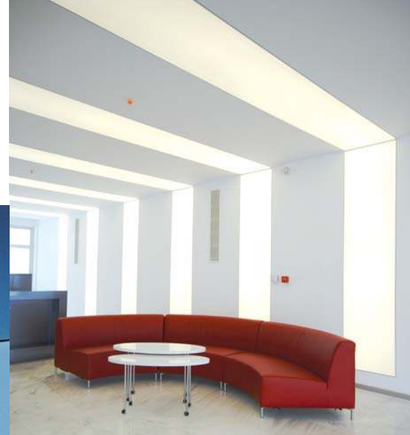
Die Kombination unifarbenener Spanndecken mit transluzenten hinterleuchteten PVC-Folien verleiht diesem Eingangsbereich seine vornehme Eleganz.
