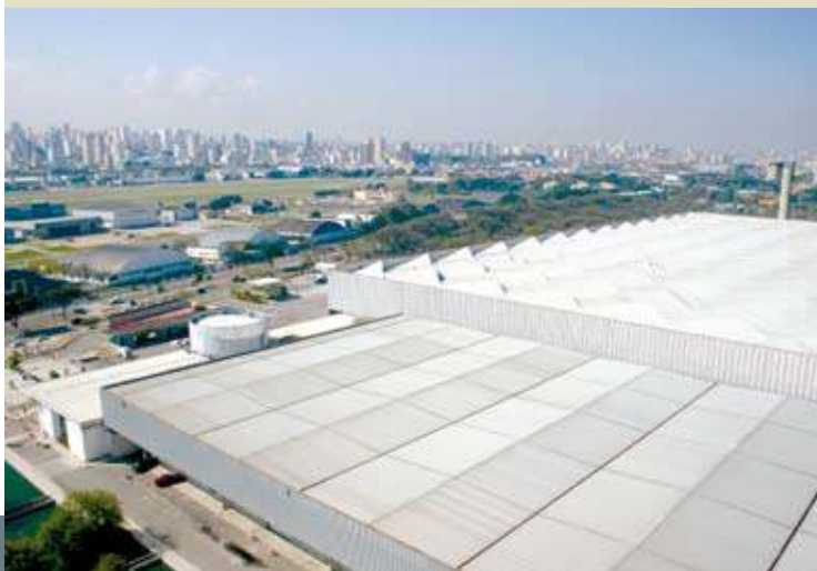
Pavillon der brasilianischen Kunststoff-Messe ‚Brasilplast‘: Das Dach der Halle wurde mit wetterbeständigen Vinyl-Membranen mit EPS-Schicht realisiert.
