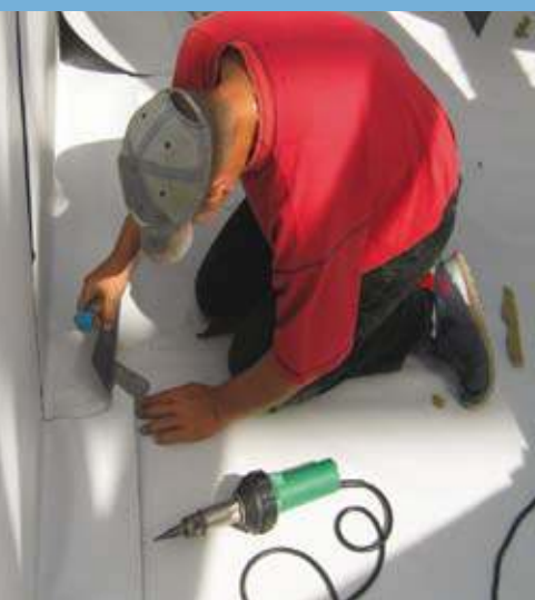
Blick auf die riesigen Bogentragwerke der stützenfreien Hallen. Die Dächer wurden mit mehrschichtigen Kunststoffplanen auf PVC-Basis abgedichtet.
