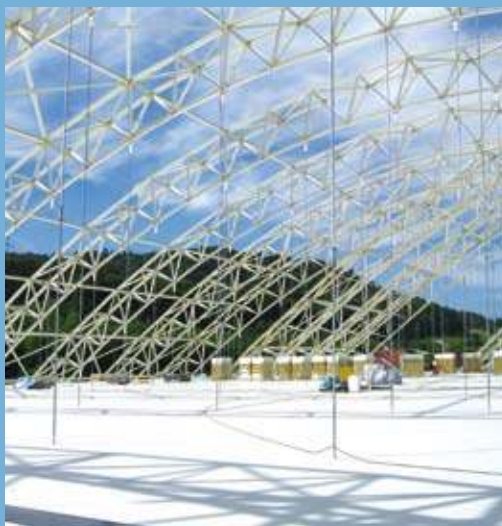
Blick auf die riesigen Bogentragwerke der stützenfreien Hallen. Die Dächer wurden mit mehrschichtigen Kunststoffplanen auf PVC-Basis abgedichtet.
