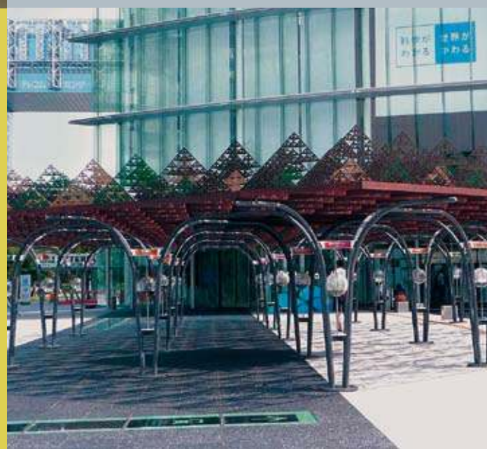
Der natürlichen Blätterform nachempfunden: Diese fragmentarische dreieckige Struktur kühlt sich durch Luftzirkulation immer wieder ab und speichert kaum Wärme.
