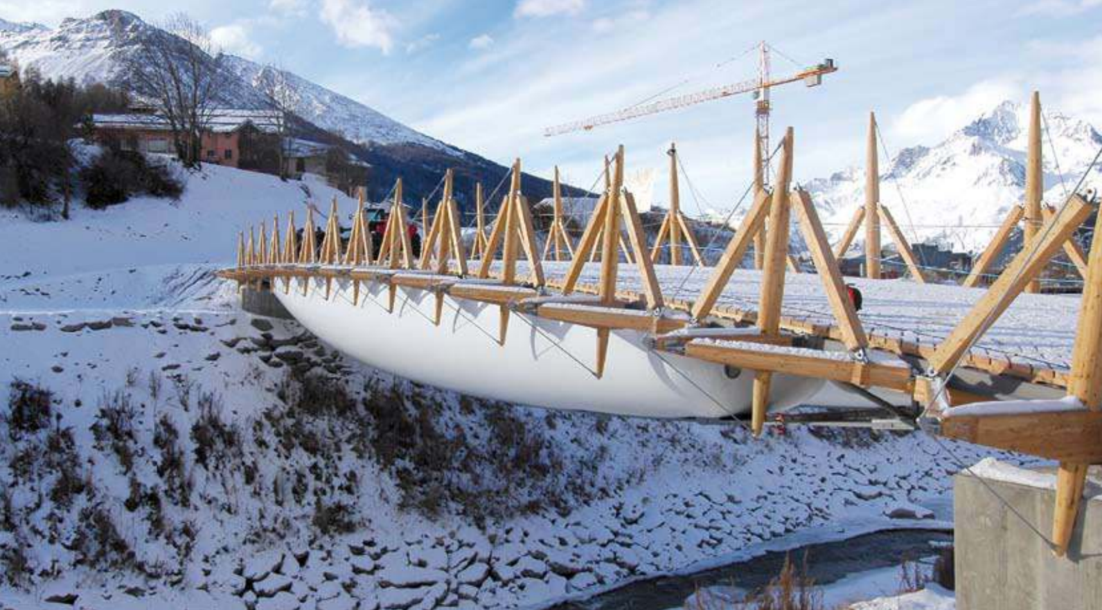
52 Meter Spannweite: Diese Skiläufer-Brücke in den französischen Alpen nutzt die pneumatische Tragstruktur Tensairity. Mit Luft gefüllte PVC-beschichtete Gewebe spielen dabei eine wichtige Rolle.
