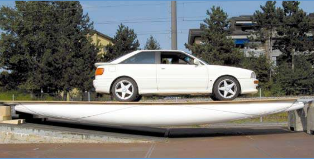
Grosse Lasten wie ein 1,5 Tonnen schweres Auto stemmt diese Demonstrationsbrücke mit acht Metern Spannweite mühelos.
