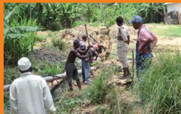
Rohr-Installation auf der Insel Pemba in Sansibar: Das neue Abwassersystem verringert die Umweltverschmutzung und verbessert die Lebensqualität der Einwohner deutlich.
