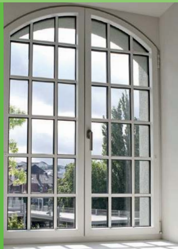
Aufgeklebte Sprossen auf den PVC-Fenstersystemen imitieren die filigrane Kleinteiligkeit der alten Stahlfenster. Der Dreh-Kipp-Flügel ist von aussen nicht sichtbar.
