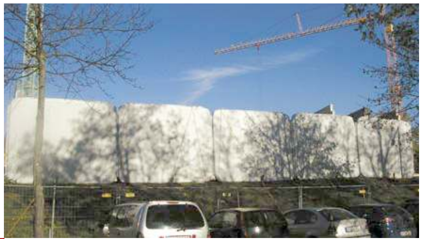
Das Aufstellen aufgeblasener PVC-Membranen wie hier an einer Baustelle reduziert akustische Störungen auf ein Minimum.
