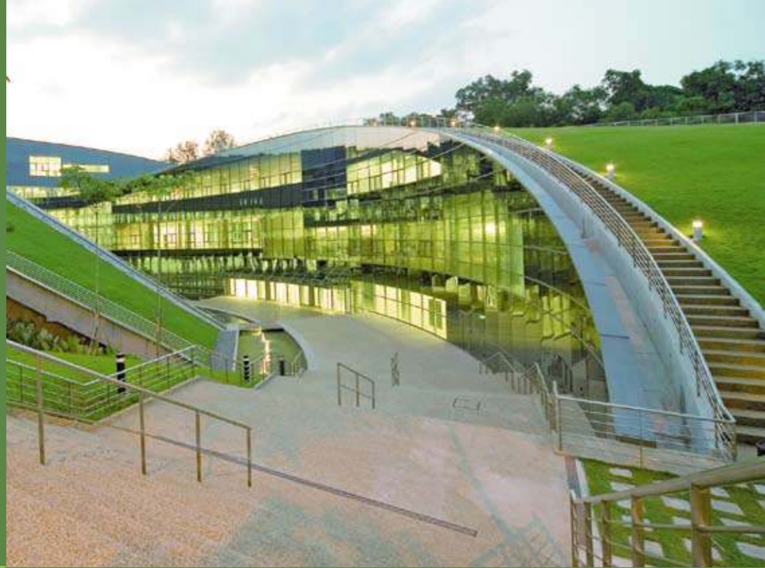
Ein geschwungenes Rasendach krönt die Designschule der Technischen Universität von Nanyang in Singapur. Der gesamte Begrünungsaufbau für die 10.000 Quadratmeter grosse Dachfläche liegt auf einer Abdichtungsbahn aus EVA und PVC.
