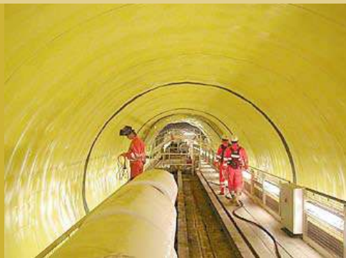
Die Auskleidung der Tunnelröhren aus PVC-Dichtungsbahnen muss den extremen klimatischen Bedingungen unter Tage bis zu 100 Jahre lang standhalten.
