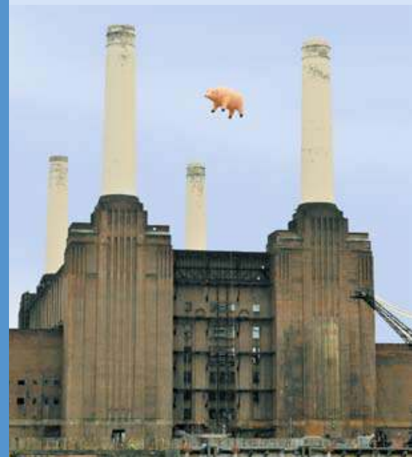
In Anlehnung an das Platten-Cover von „Animals“, das vor 35 Jahren entstand, schwebt ein neues aufgeblasenes PVC-Schwein über dem ehemaligen Kohlekraftwerk Battersea Power Station in London.
