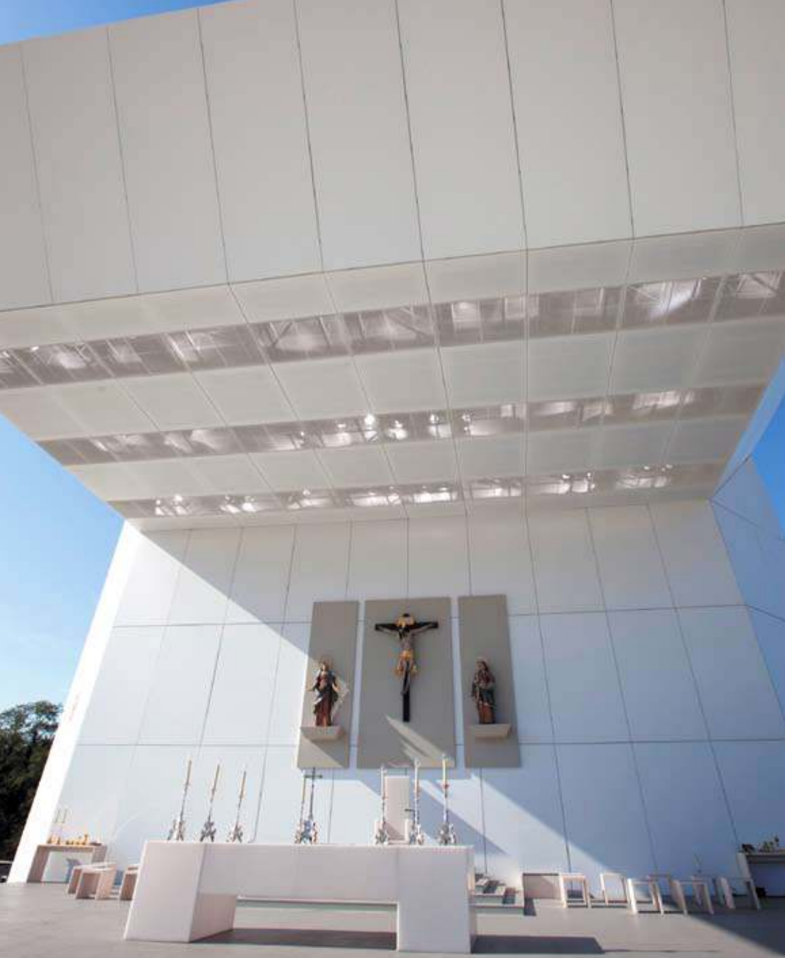
Wahrzeichen der Altarinsel: Das 16 Meter auskragende Dach mit integrierter Licht- und Beschallungstechnik. Zur Verkleidung des temporären Bauwerks wurden 1.250 Quadratmeter PVC-beschichtete Polyestermembranen gespannt.
