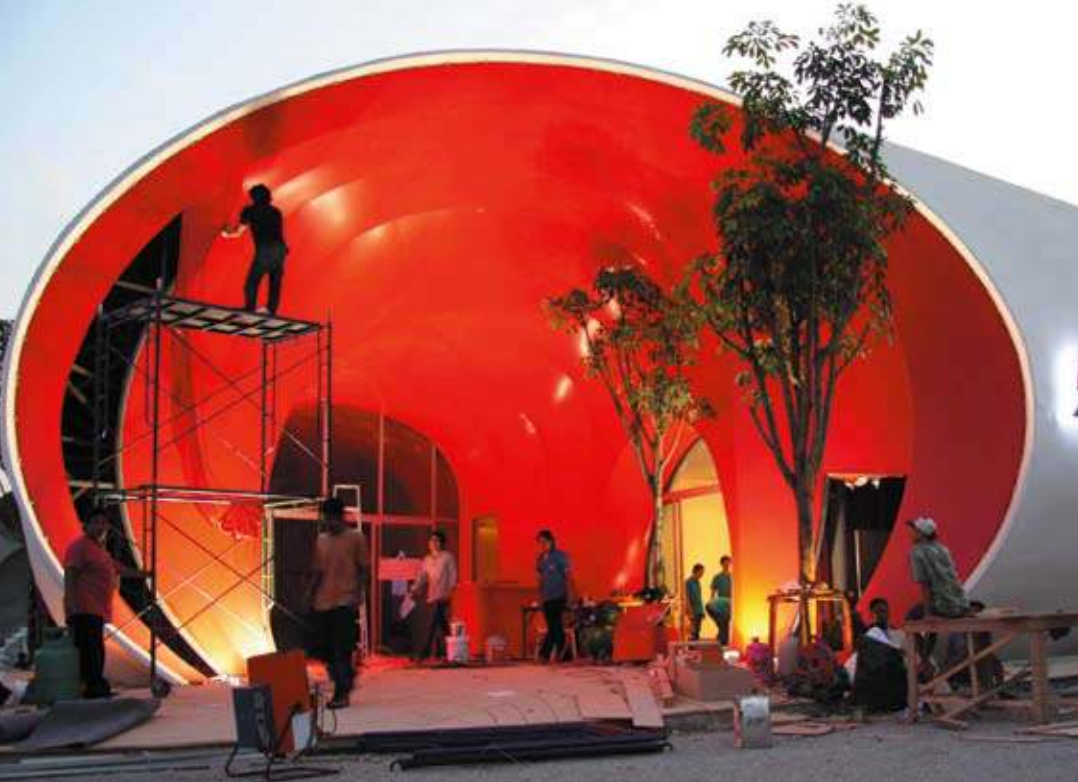
Der Bridgestone-Pavillon kurz vor seiner Fertigstellung: Im Eingangsbereich werden die letzten roten PVC-Membranen angebracht.
