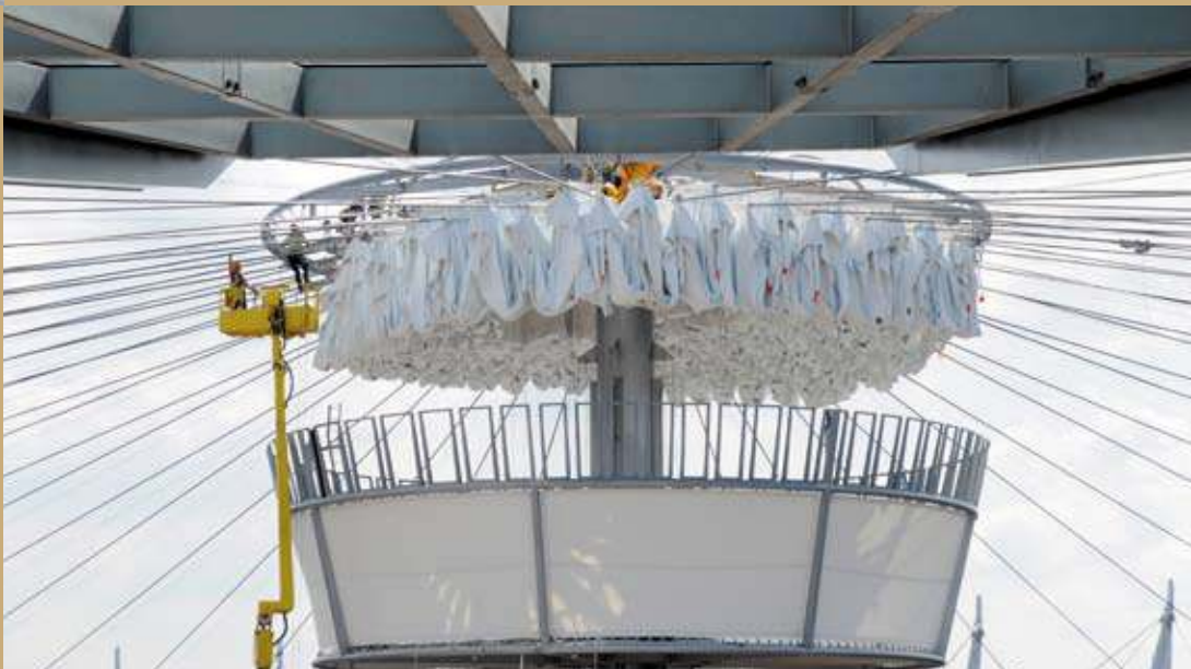
Die PVC-beschichteten Polyesterergewebe des inneren Stadionsdaches verschwinden in einer schwebenden Garage. Nur bei schlechtem Wetter werden sie zu einem schützenden Dach auseinandergefaltet.
