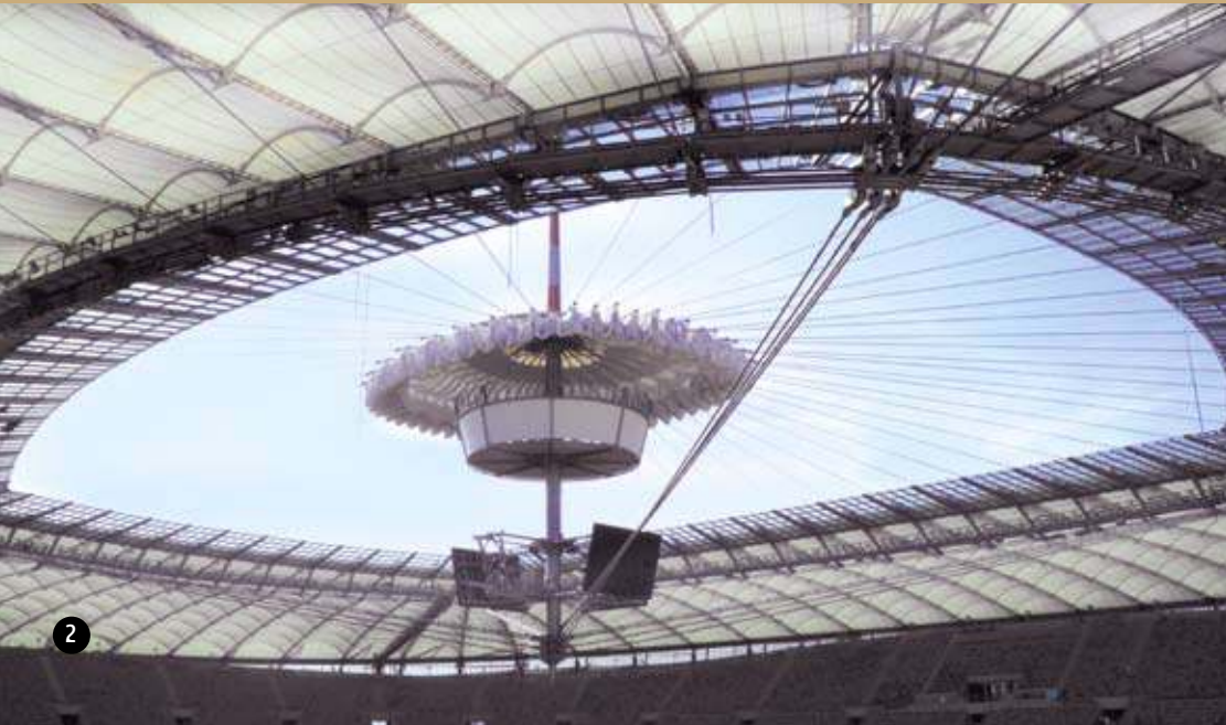
Das innere Dach des Warschauer Fußballstadions lässt sich in etwa 20 Minuten auseinanderfalten und überspannt dann das Spielfeld.
