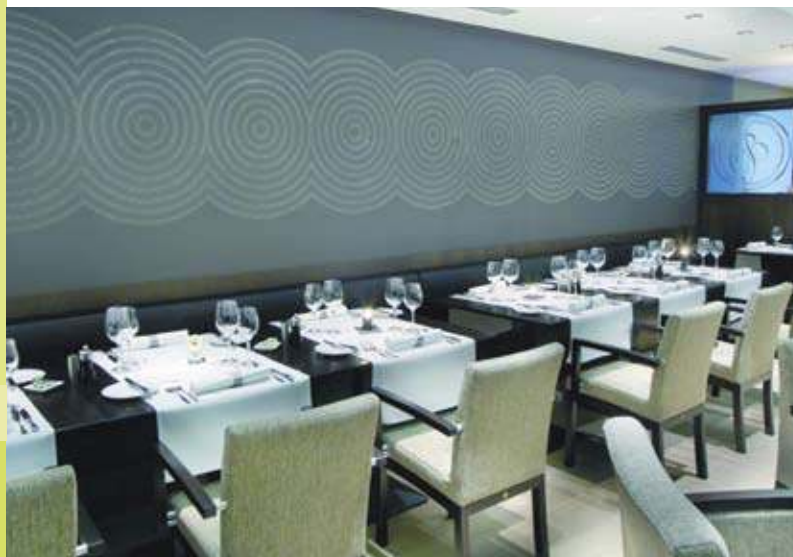
Im Restaurant Brouwershof in Lokeren/Belgien kam eine Vliestapete mit anthrazit-farbener Vinylschicht an die Wand. Aufkaschierte PVC-Granulate in konzentrischen Kreisen erzeugen einen dreidimensionalen Effekt.
