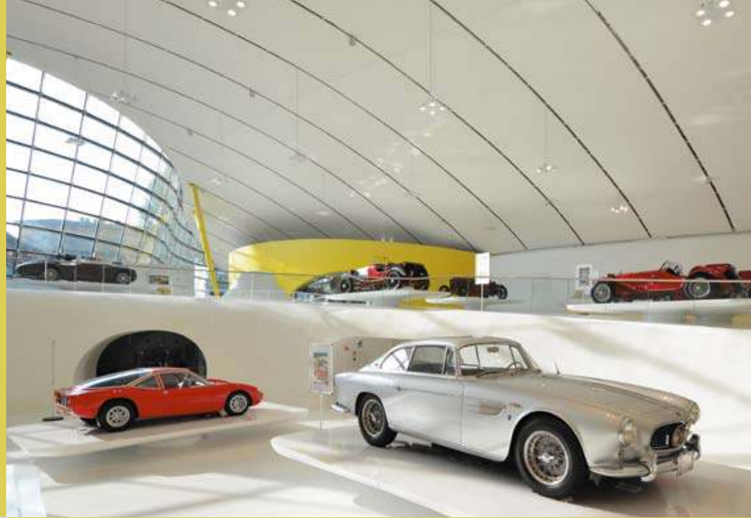
Ein beeindruckendes Gewölbe, verkleidet mit 2.700 Quadratmetern PVC-Spanndecken von Barrisol®, beherbergt die Sammlung der symbolträchtigen italienischen Automodelle, die bis Oktober zu sehen waren.
