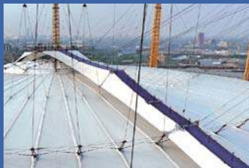
Der Weg über die Konzerthalle erstreckt sich über eine Länge von 350 Metern. Foto: mit freundlicher Genehmigung von Base Structures
