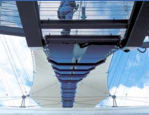
Blick von unten: Der blaue Laufsteg aus Membranen mit seinen seitlichen Sicherungsnetzen führt komplett über die Musikarena. Foto: Tony Sprawson
