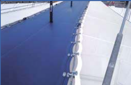
Blick von der Aussichtsplattform „Up at The O2“ auf den blauen PVC-beschichteten Membranweg und die seitlich angebrachten weißen Sicherungsnetze aus Mesh-Gewebe. Foto: Tony Sprawson
