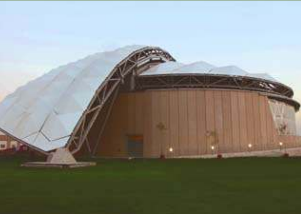
Das zweigeteilte Dach übernimmt eine wichtige Funktion, damit das Stadion angenehm temperiert ist. Der kleinere Teil kann bei Bedarf in Rotation versetzt werden, um die Dachfläche zu öffnen oder zu schliessen.
