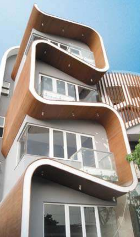
Diese geschwungene Fassade einer privaten Villa in Ho-Chi-Minh-Stadt in Vietnam ist mit Resysta-Elementen gestaltet: ein eindrucksvolles Beispiel für die aussergewöhnliche Formbarkeit des Materials.
