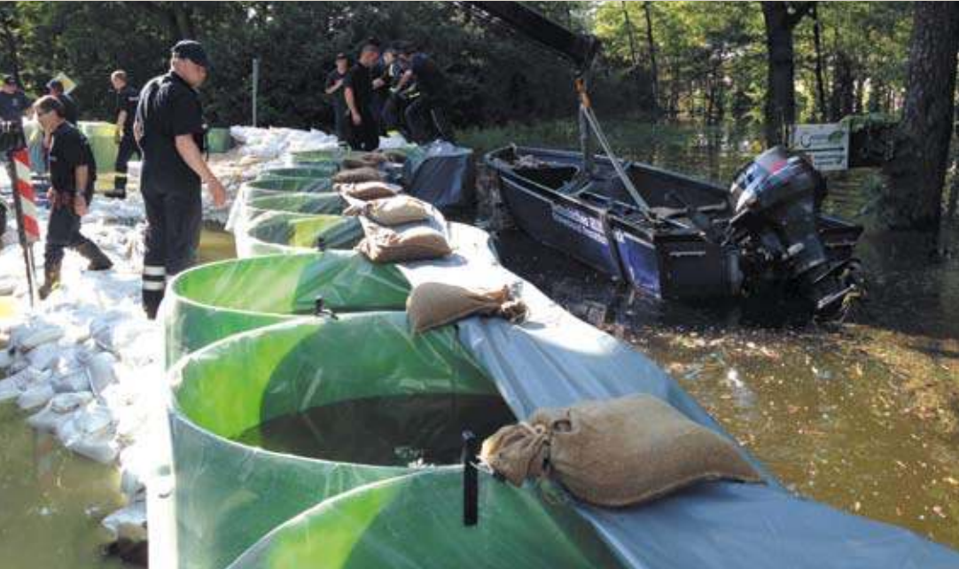
Voll im Einsatz: Die mit Wasser befüllten Zylinder wurden von Feuerwehr und THW mit extrem reissfesten PVC-Folien abgedichtet und bei Gartow auf 1,568 Metern Länge eingesetzt, um das Hochwasser in Schach zu halten.
