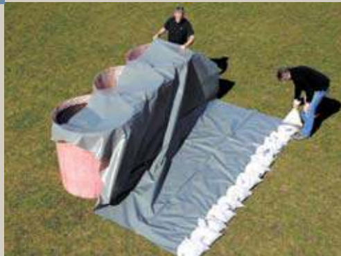
Genial einfaches Prinzip: Eine GFK-Platte wird zu einem Zylinder gebogen und mit Folie ausgekleidet. Danach füllen die Hilfskräfte die Röhre mit Wasser und dichten das System zur Hochwasserseite hin mit PVC-Folie ab.
