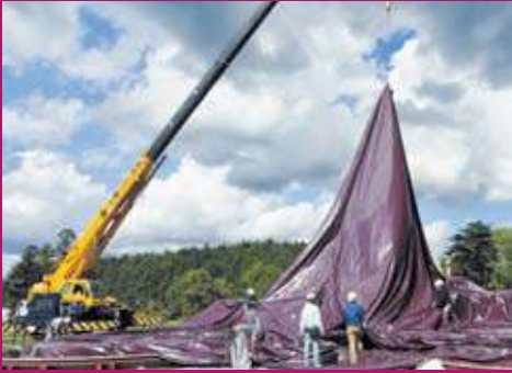
Ein Kran zog die Membran der mobilen Konzerthalle in die Höhe, um sie anschliessend aufzublasen.
