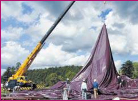
Ein Kran zog die Membran der mobilen Konzerthalle in die Höhe, um sie anschliessend aufzublasen.
