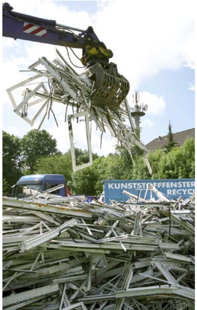
Die Sammlung und Wiederverwertung ausgebauter PVC-Fenster-Systeme ist heute gängige Praxis. Am Ende des Prozesses stehen moderne Wärmedämmfenster, die Energie sparen und das Wohnklima verbessern.
