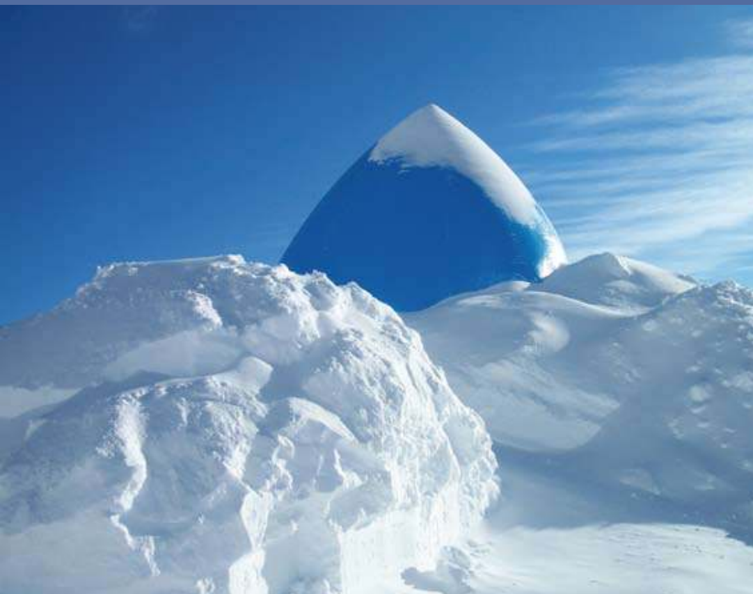
Aufgeblasene Ballone aus elastischen PVC-Planen dienen den Iglu-Dörfern als Formgeber.
