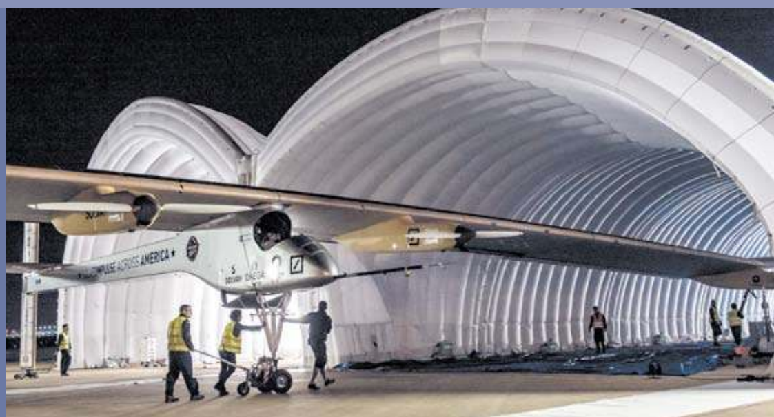
Falls das Solarflugzeug auf seiner Weltumrundung mal eine Halle benötigt, kann in nur wenigen Stunden dieser aufblasbare Hangar errichtet werden.
