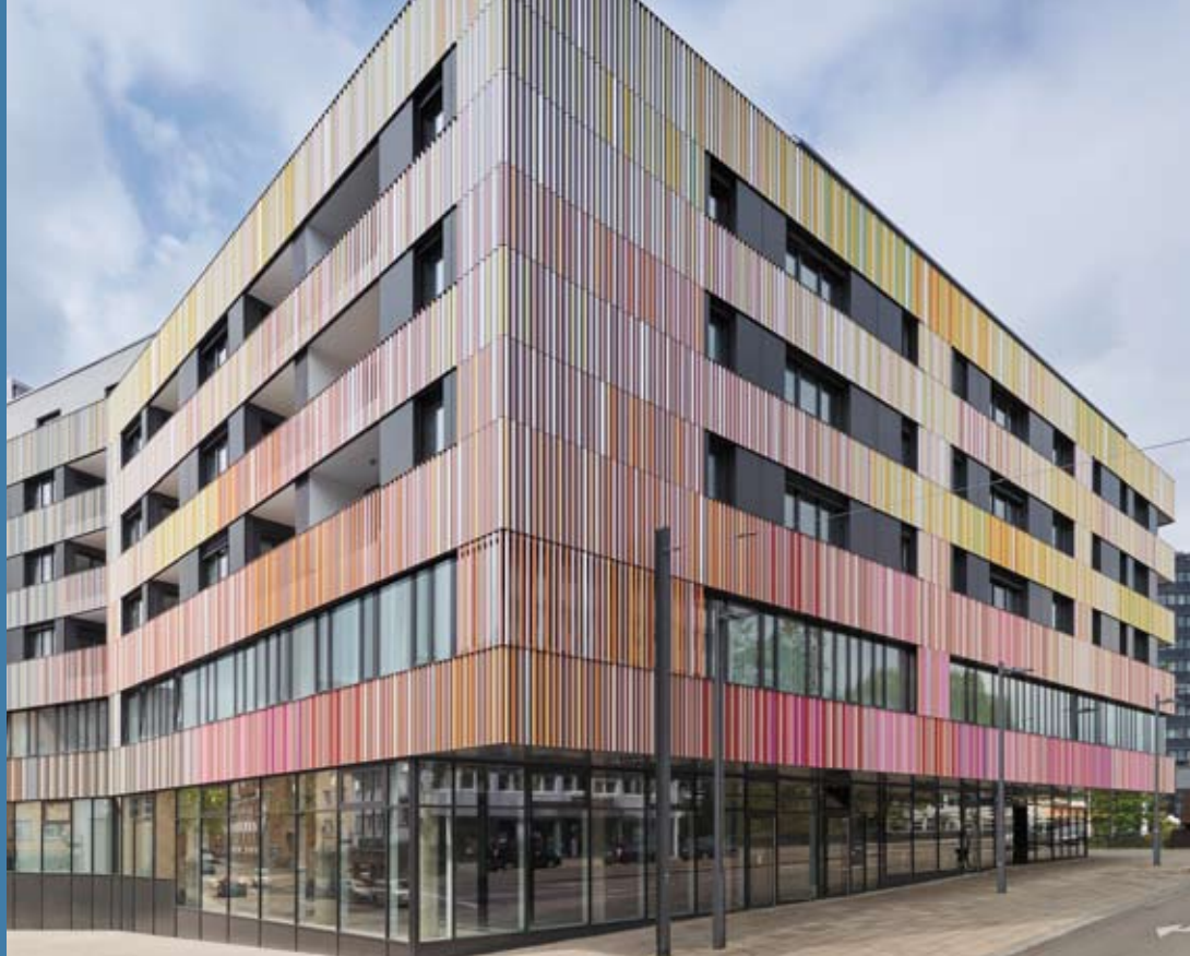
Der Maler Antonio Marra entwarf das Farbkonzept für die Lamellen-Fassade des MARRAHAUS in Heilbronn, das der Innenstadt jetzt eine neue Identität verleiht.
