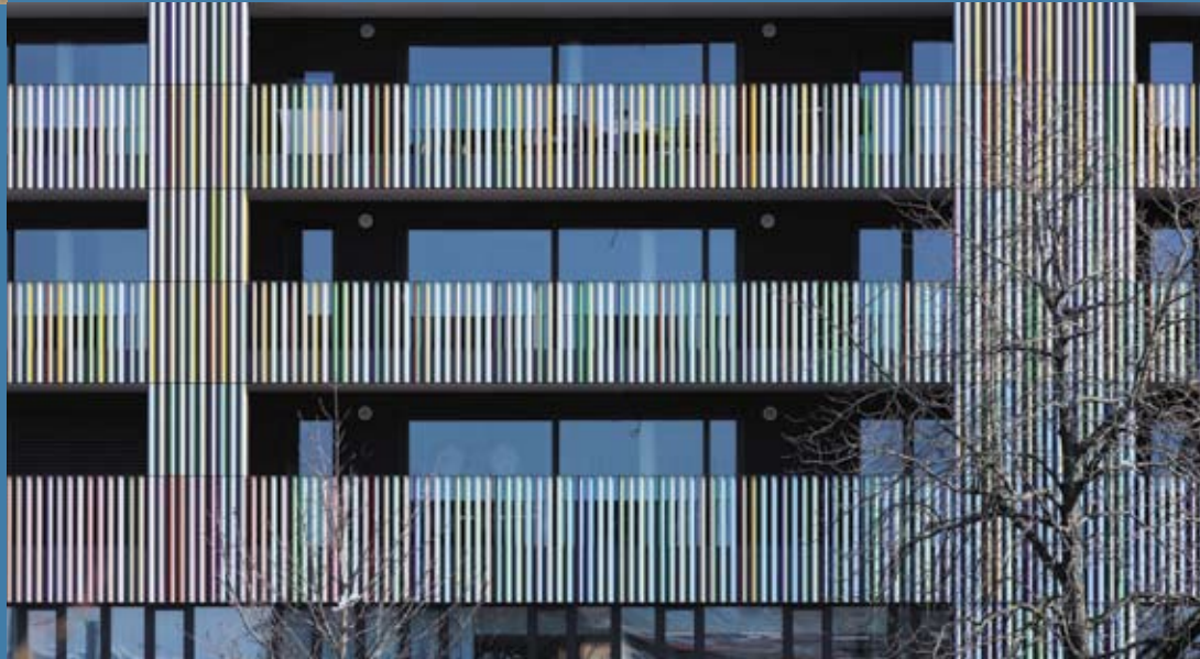
Energiesparfenster aus Kunststoff mit blaugrauer Alu-Deckschale sind Teil der künstlerischen Fassade und integrieren sich ideal in das von Antonio Marra entwickelte Farbkonzept.
