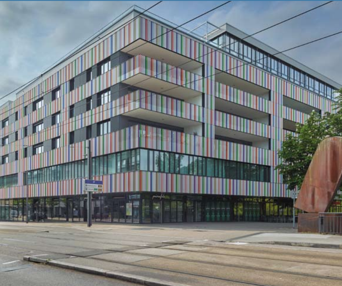
An diesen beiden Fassadenseiten liegt der Weissanteil der Lamellen bei 50 Prozent. Auf zwei weisse Elemente folgen jeweils zwei farbige Lamellen.
