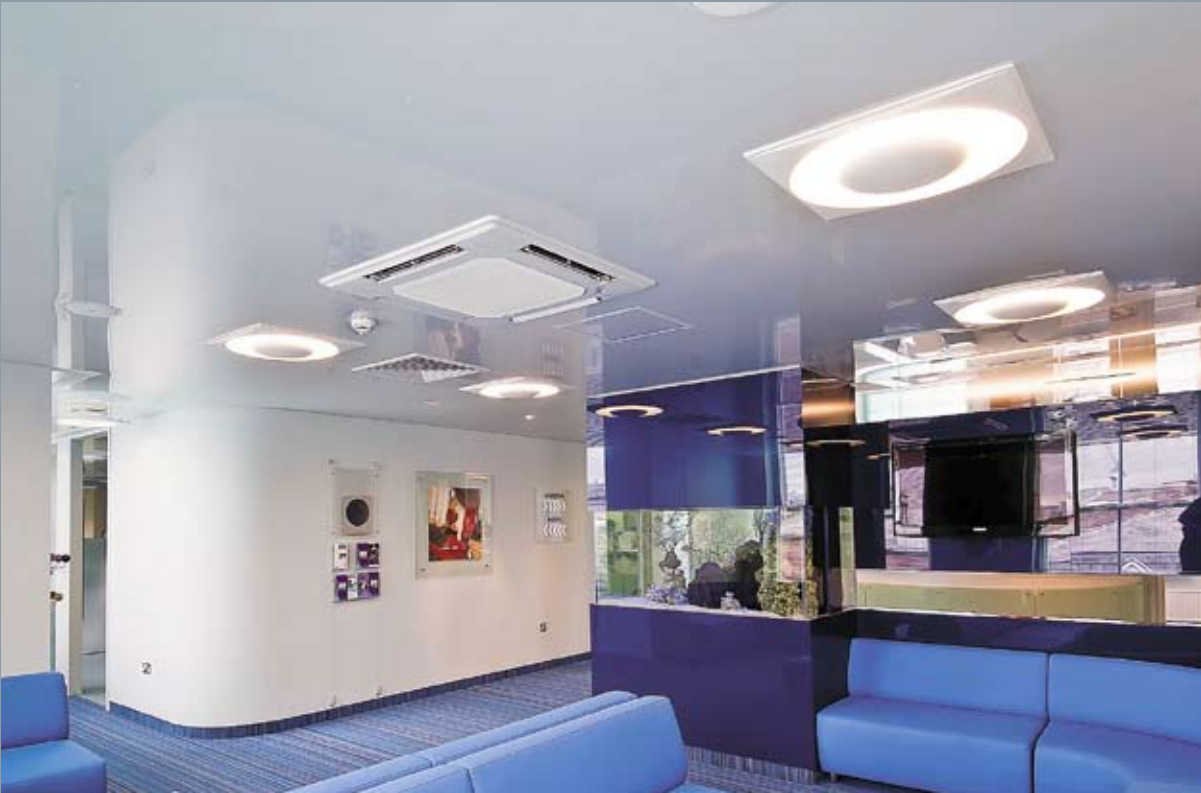
Die reflektierende weiße Spanndecke im Warteraum dieser Zahnklinik lässt den Raum hell und freundlich erscheinen.
