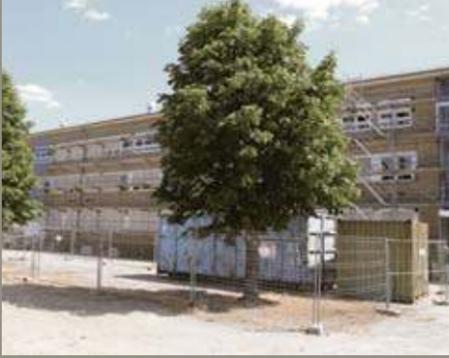
Die Sekundarschule Nord in Jessen (Elster) wird bis 2019 bei laufendem Schulbetrieb energetisch saniert und erhält dabei auch neue Kunststofffenster mit Dreifachverglasung. Im Rahmen des öffentlich geförderten Sanierungsvorhabens werden auch ca. 700 PVC-Altfenster ausgebaut, recycelt und wiederverwertet. Foto: Rewindo
