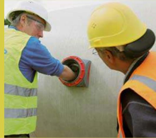
Ob Kunststoff, Beton oder Steinzeug: Der Anschluss kann bei unterschiedlichen Werkstoffen eingesetzt werden, unabhängig von Rohrrinnendurchmesser und Rohrwanddicke.
