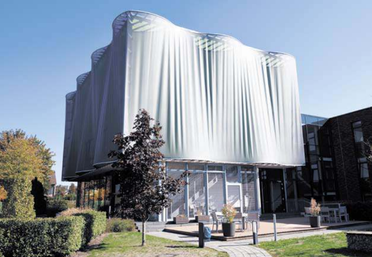
Die metallisch schimmernden Membranen an der Musikschule in Erfstadt umhüllen den Konzertsaal im Obergeschoss in eleganter Faltenoptik.
