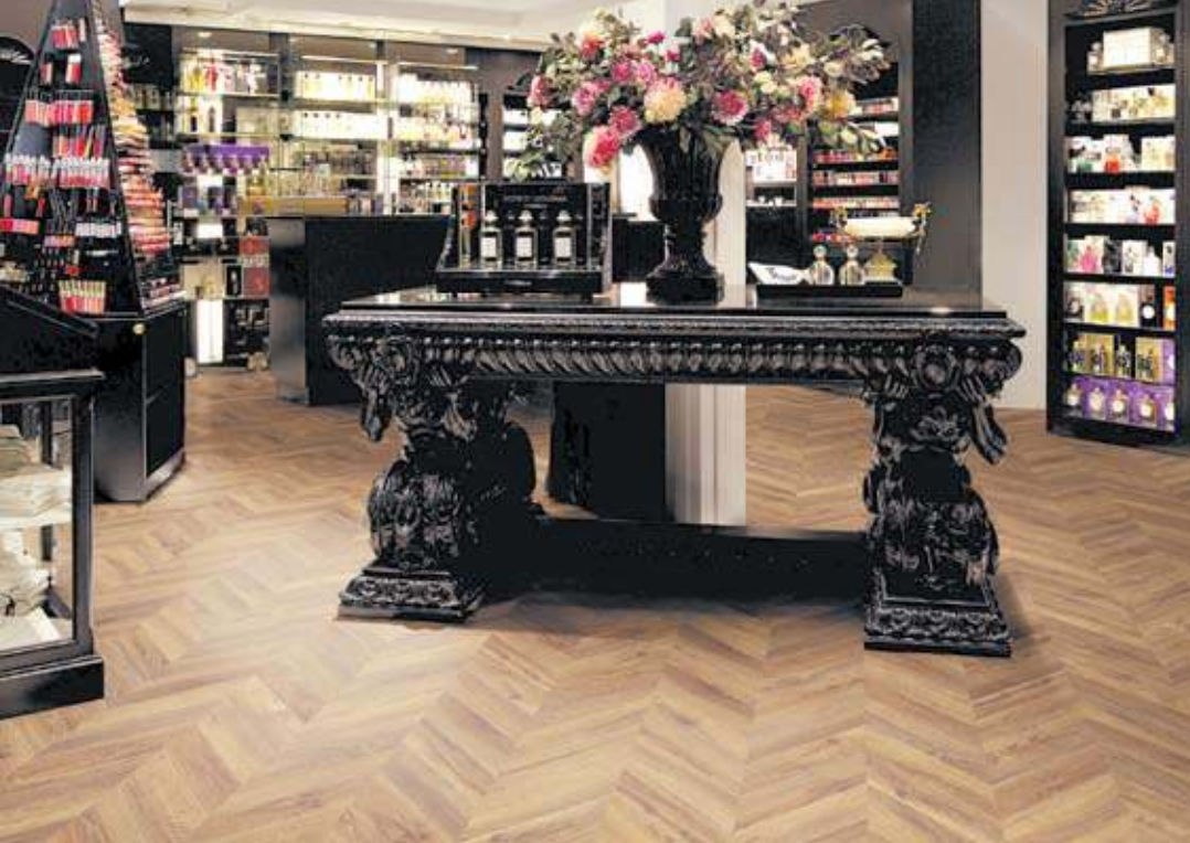
Die im 60°-Winkel angeschrägten Planken in dieser Parfümerie sind im Chevron-Muster verlegt, einer klassischen Verlegetechnik aus dem Parkettbereich.
