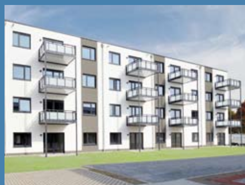
Foto oben und rechts: Diese VONOVIA-Wohnanlage in Wiesbaden entstand mit Hilfe eines modularen Baukastens mit Standardgrundrissen und besteht aus insgesamt 118 präzise vorgefertigten Modulen, die in nur zwei Monaten montiert und bezugsfertig ausgebaut wurden.
