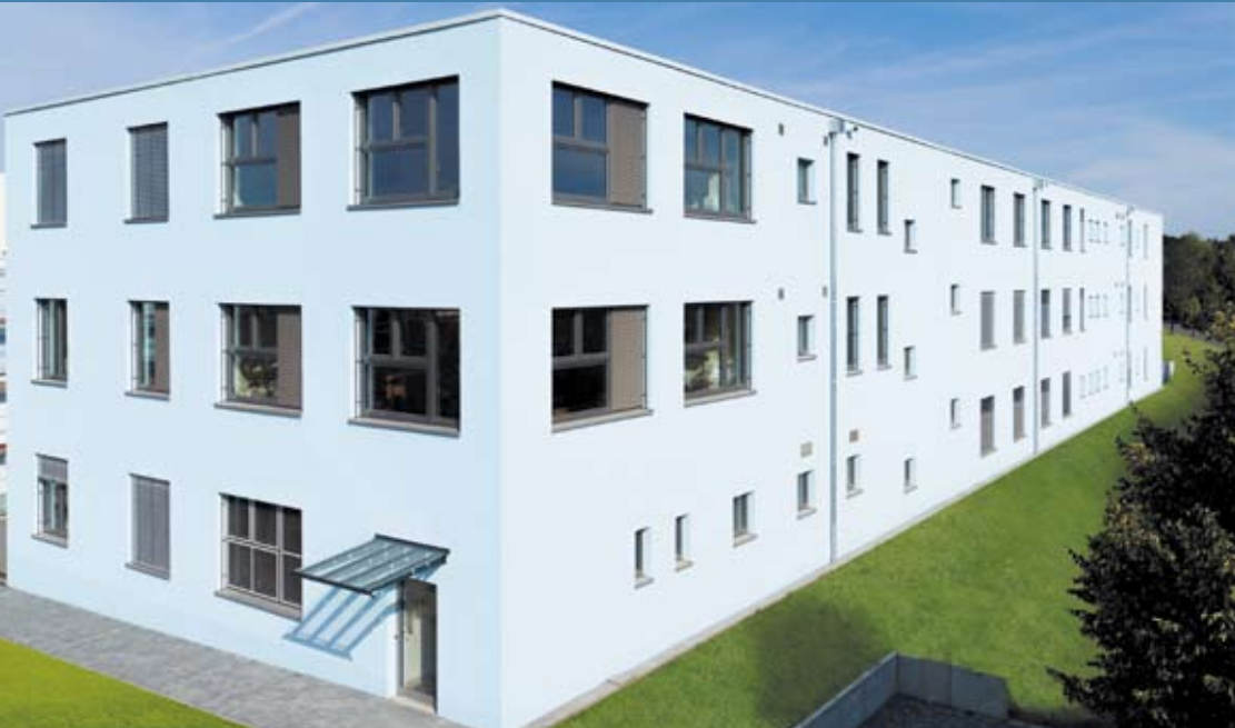
Die Module der Meissener Grundschule wurden mit Energiesparfenstern aus Kunststoff in elegantem Grau ausgestattet.
