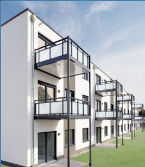
Foto oben und rechts: Diese VONOVIA-Wohnanlage in Wiesbaden entstand mit Hilfe eines modularen Baukastens mit Standardgrundrissen und besteht aus insgesamt 118 präzise vorgefertigten Modulen, die in nur zwei Monaten montiert und bezugsfertig ausgebaut wurden.
